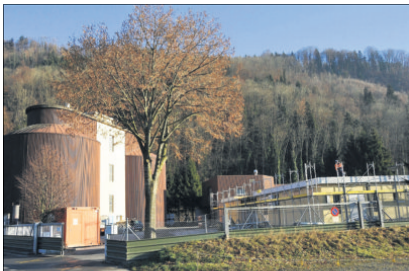
Im Rahmen des ARA-Ausbaus werden die Aufstockung und der Umbau des Betriebsgebäudes (rechts) vorgezogen. Bild Robert Hess
